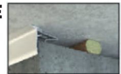
Bourrelet coupe feu avec couvre joint.
