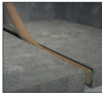
Avant que la colle ne sèche, introduire le bourrelet coupe-feu
