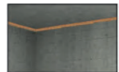
Bourrelet coupe feu sans couvre joint.
